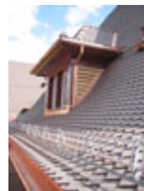
Dach mit neuen Biberschwanzziegeln
