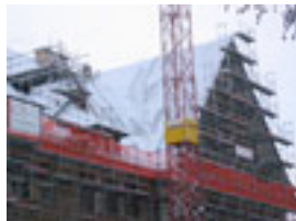
Bauarbeiten im Winter
