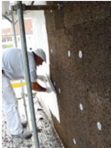
Aussen-Wärmedämmung mit Korkplatten
