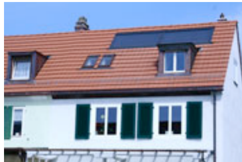
Solare Warmwasserproduktion oben
